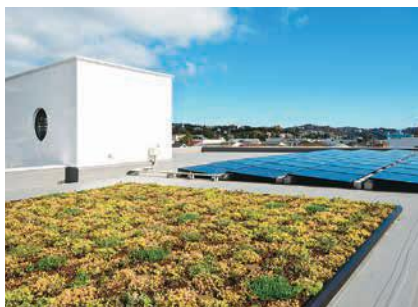
太陽光パネルを設置し、屋上緑化にも取り組む
